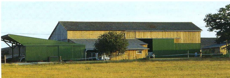
Bâtiment agricole avec bardage bois – Source : Photographie Rapilliard
