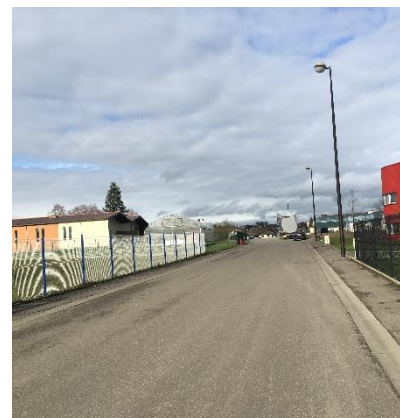
VOIRIE AVEC TROTTOIR ET ÉCLAIRAGE
