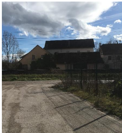
ZONE BORDÉE PAR LA VOIE FERRÉE
