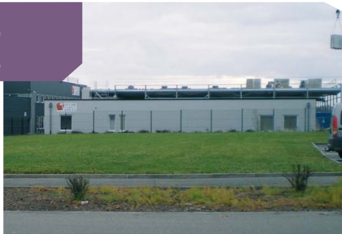
Travaux extension de la Case aux épices.
