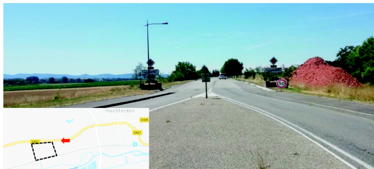
Vue depuis la RD421 vers Dettwiller (vers l'Ouest) au niveau du carrefour menant au centre équestre / Source : Egis
